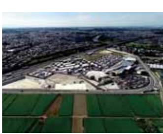
蓮田サービスエリア (上り)
