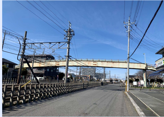
▲町道792号線浅草側歩道橋
