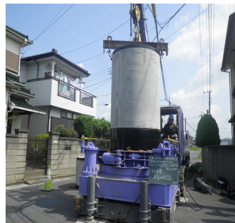
▲人孔吊り込みの様子
