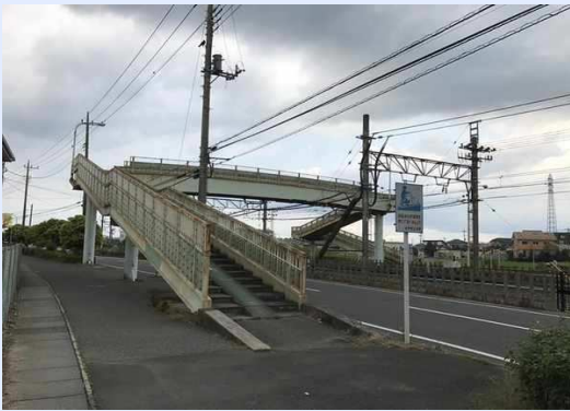
▲町道795号線日光側歩道橋
