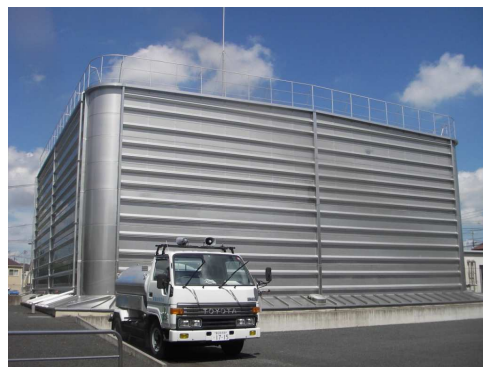
▲第一配水場配水池
