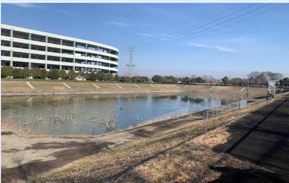
▲深輪産業団地調整池
