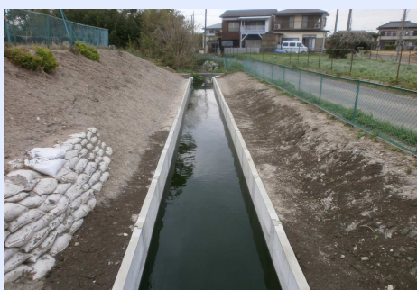
▲南側水路（堤根）
