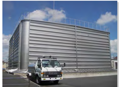
▲第一配水場配水池
