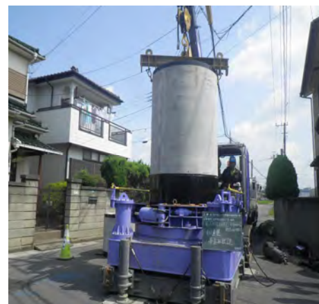
▲人孔吊り込みの様子
