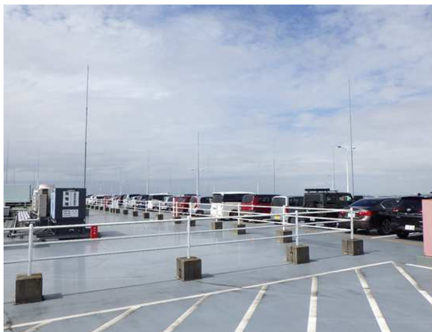
受入れ施設（GLP 杉戸Ⅱ） 屋上駐車場▶
