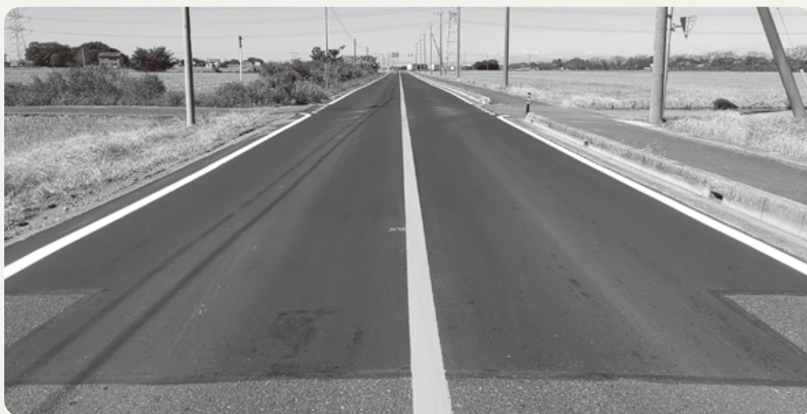
町道 I 級 11 号線(埼玉広域農道)
