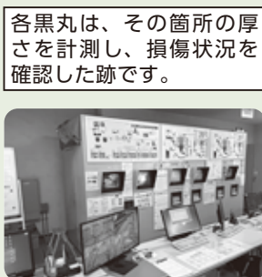
中央制御室モニター
