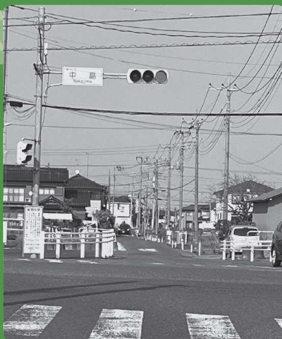
新橋通り線予定地
