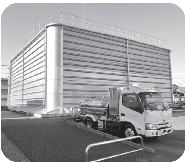
▲ 杉戸1丁目にある第一配水場と給水車
