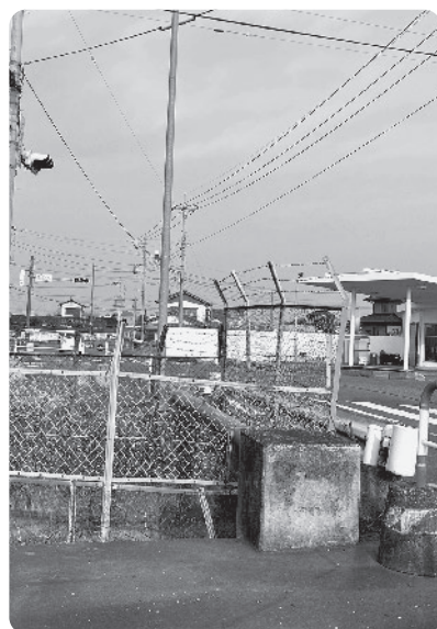
次木杉戸線の工事箇所
