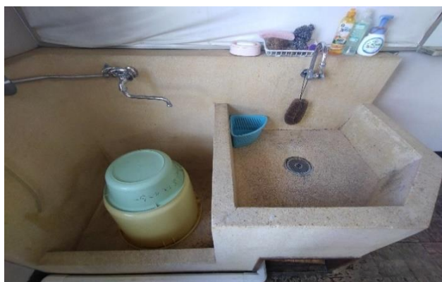
▲ 流し場（実習室壁側） 1台
