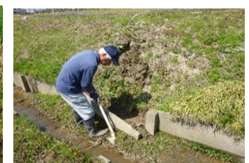
・水路修繕(茨島)
