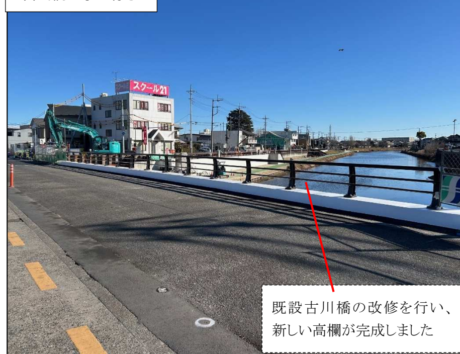
古川橋工事の様子
