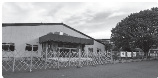
▲ 工事がはじまる体育館
