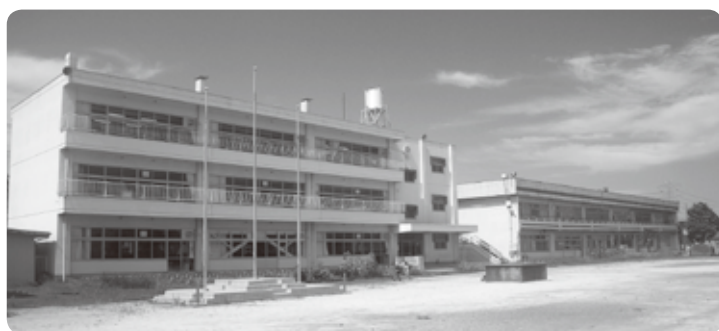
改修予定の校舎
