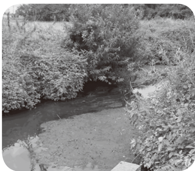
▲ ヘドロが堆積した根用水
