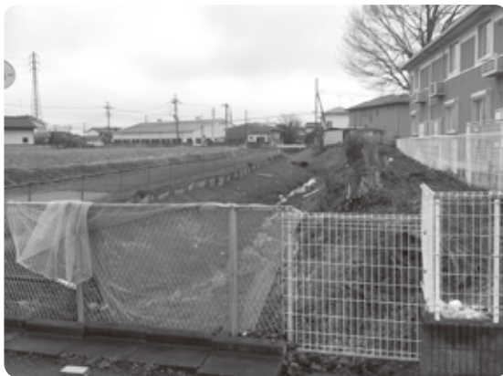
5ページの工事の下流部
