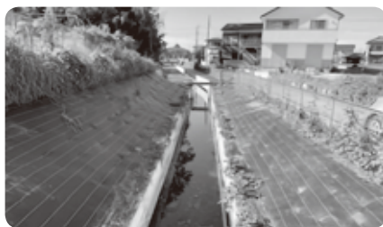
改修した南側水路（堤根）
