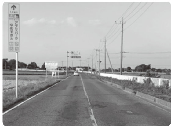
町道Ⅰ級11号線（広域農道）
