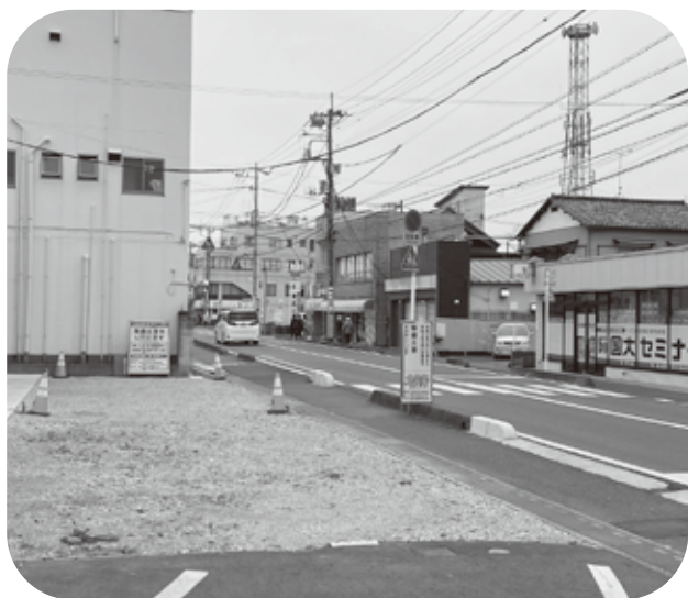
▲ 整備へ向けて進む東武動物公園駅東口通り線
