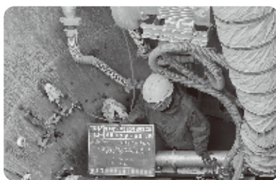
下水道工事の現場
