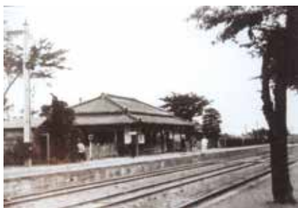
▲杉戸駅(明治末期：現東武動物公園駅)
