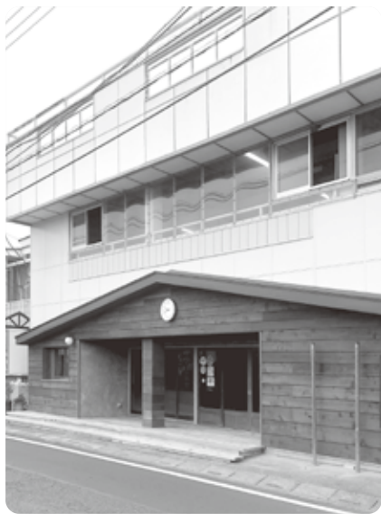
改修中の流灯工房
