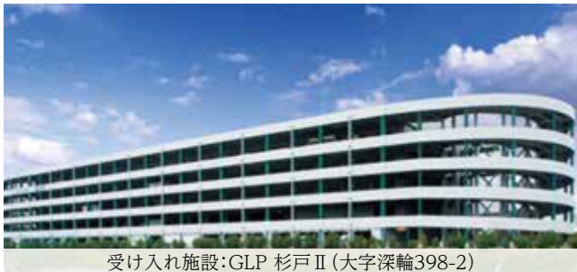
受け入れ施設：GLP 杉戸Ⅱ (大字深輪398-2)
