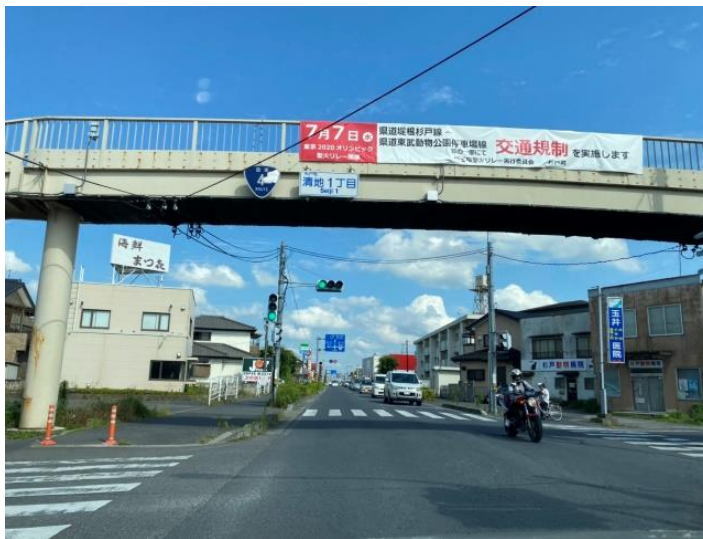
◀ 歩道橋に設置された様子
