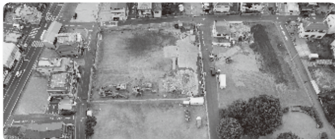
工事が進む旧杉戸小学校跡地
