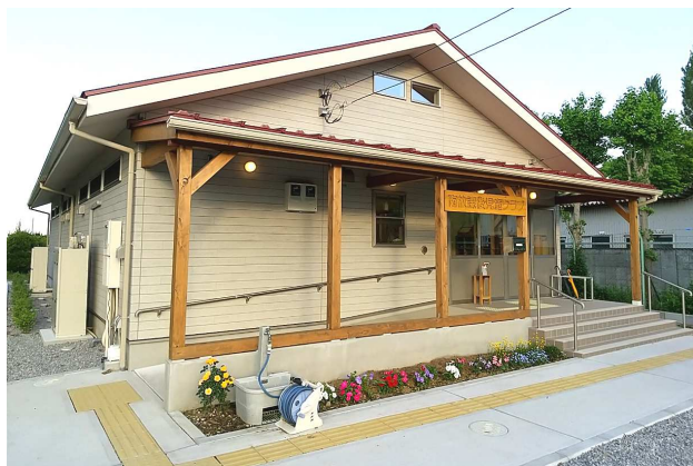
木の柱、梁をくぐり入る玄関 ※名称板は日本工業大学が製作・取付
