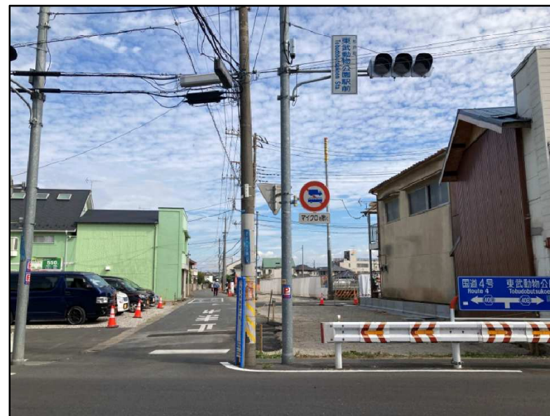
工事中写真(町道92号線)
