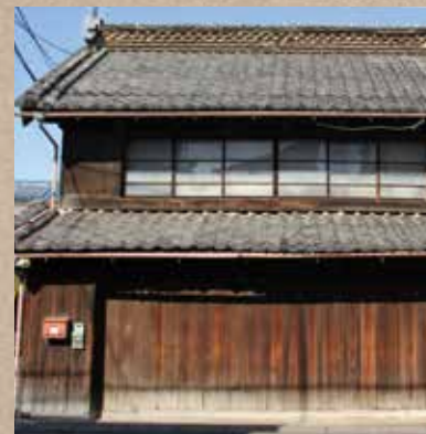
跡地に建てられた古民家
