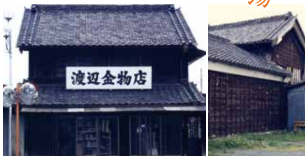
屋号を掲げていた頃の建物正面と歴史を語る板張りの外壁
