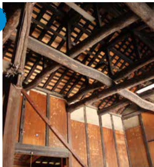
蔵の内部には縦横に走る梁や桁
