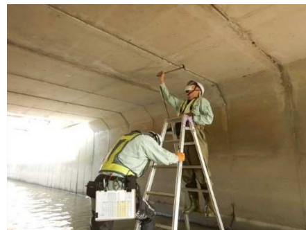
脚立・梯子による点検
