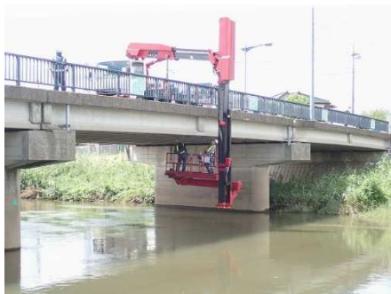
橋梁点検車による点検
