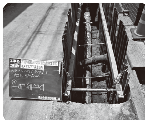
大字下高野地内高野団地公共下水道工事に係る配水支管布設替工事（第5工区）
