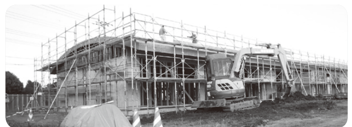
建設中の統合幼稚園・保育園複合施設
