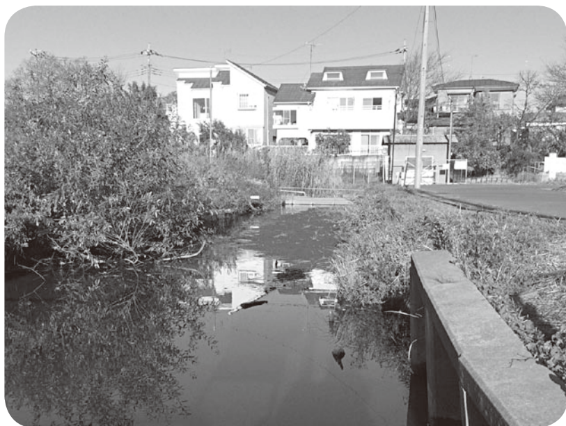
早期の改修工事が望まれる根用水路（木野川地区）
