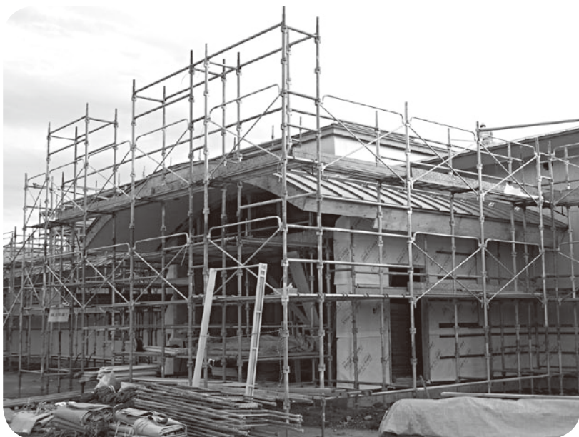
開園目指して、工事急ピッチ！！
