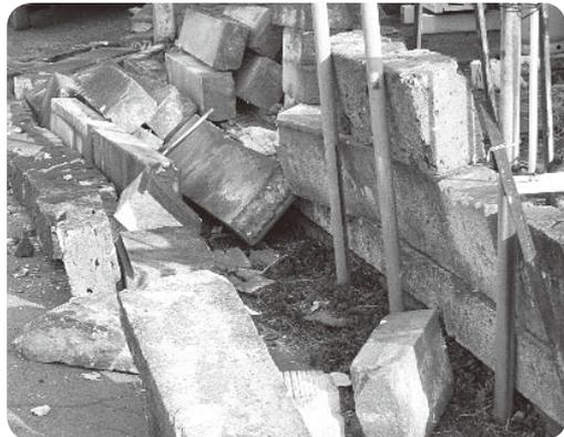
地震により倒壊した塀（町内）
