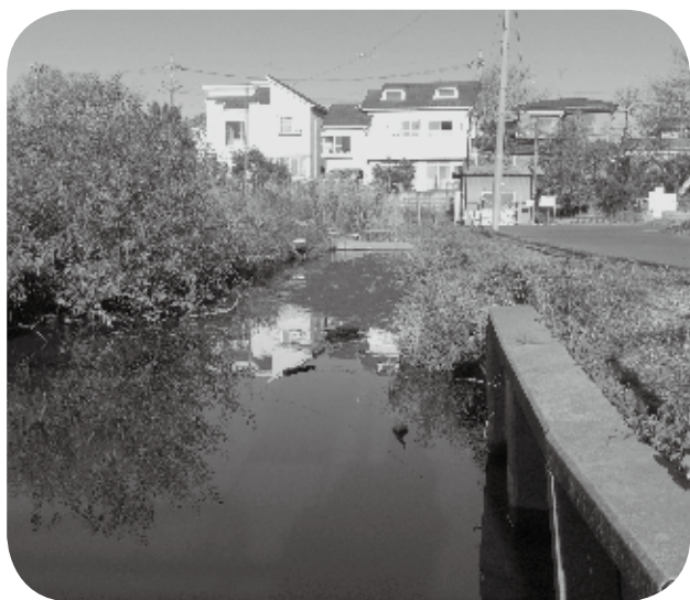
▲ 冠水時の安全対策からフェンス設置を合意
