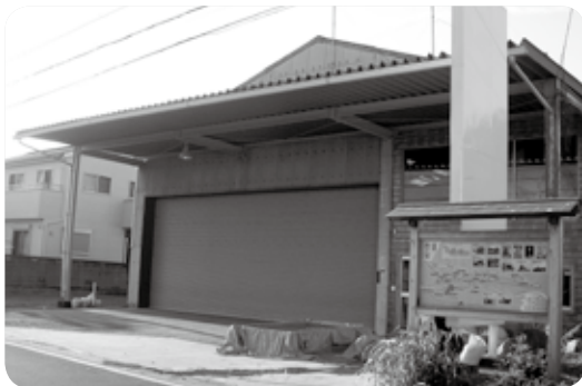
(仮称)第2流灯工房
