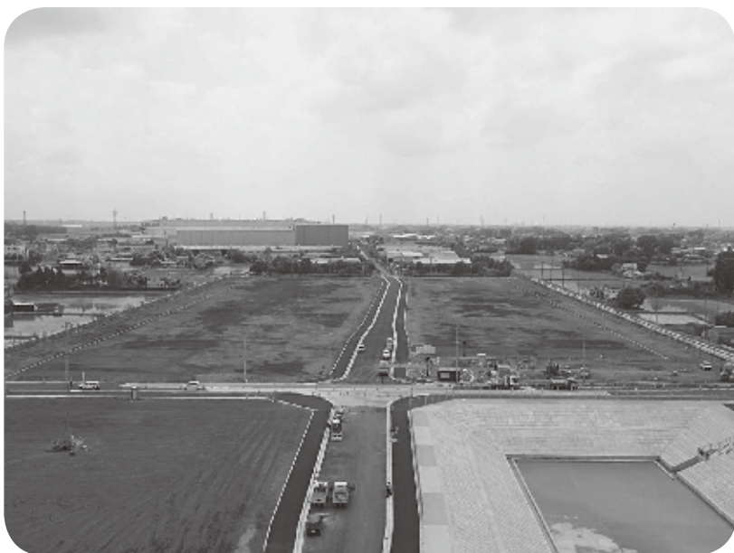
いよいよ工事完了する屏風深輪産業団地
