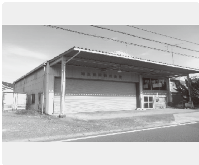
解体し新築工事中
