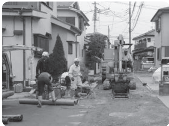
内田 4 丁目地内の整備工事
