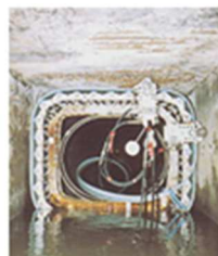
プラスチック材により既設管渠の内面を被膜
