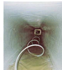
プラスチック材により既設管渠の内面を被膜
